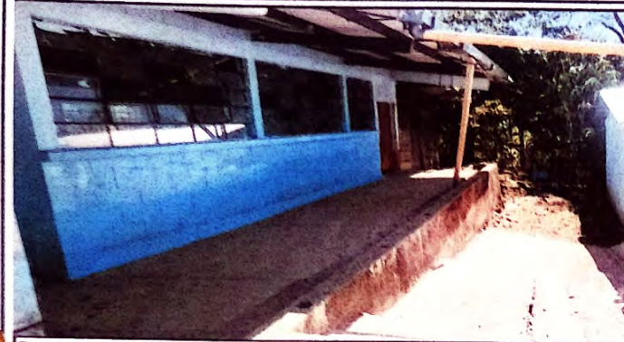
Foto 1: colocacion de barranda
