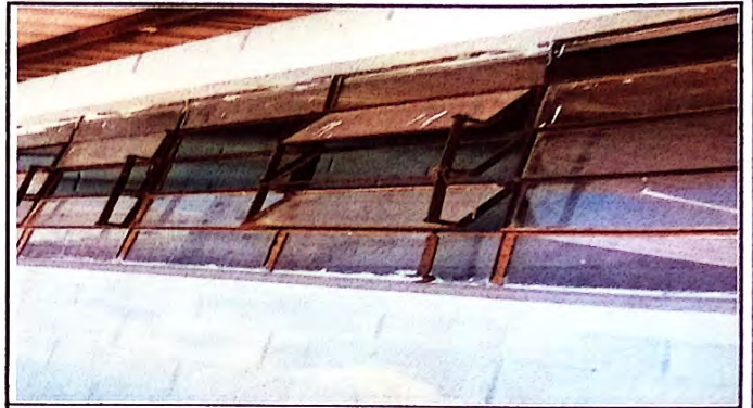
Foto 2: sustitucion de vidrios
