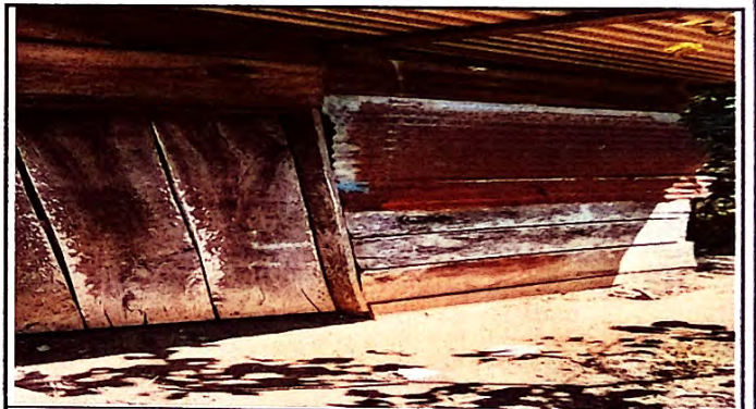
Foto 4: repacion y ampliacion de area cocinas
