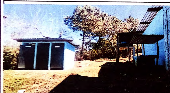
Foto 3: sistema de coptacion de agua
